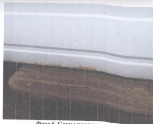
Фото 6. Следы коррозии ступенек
